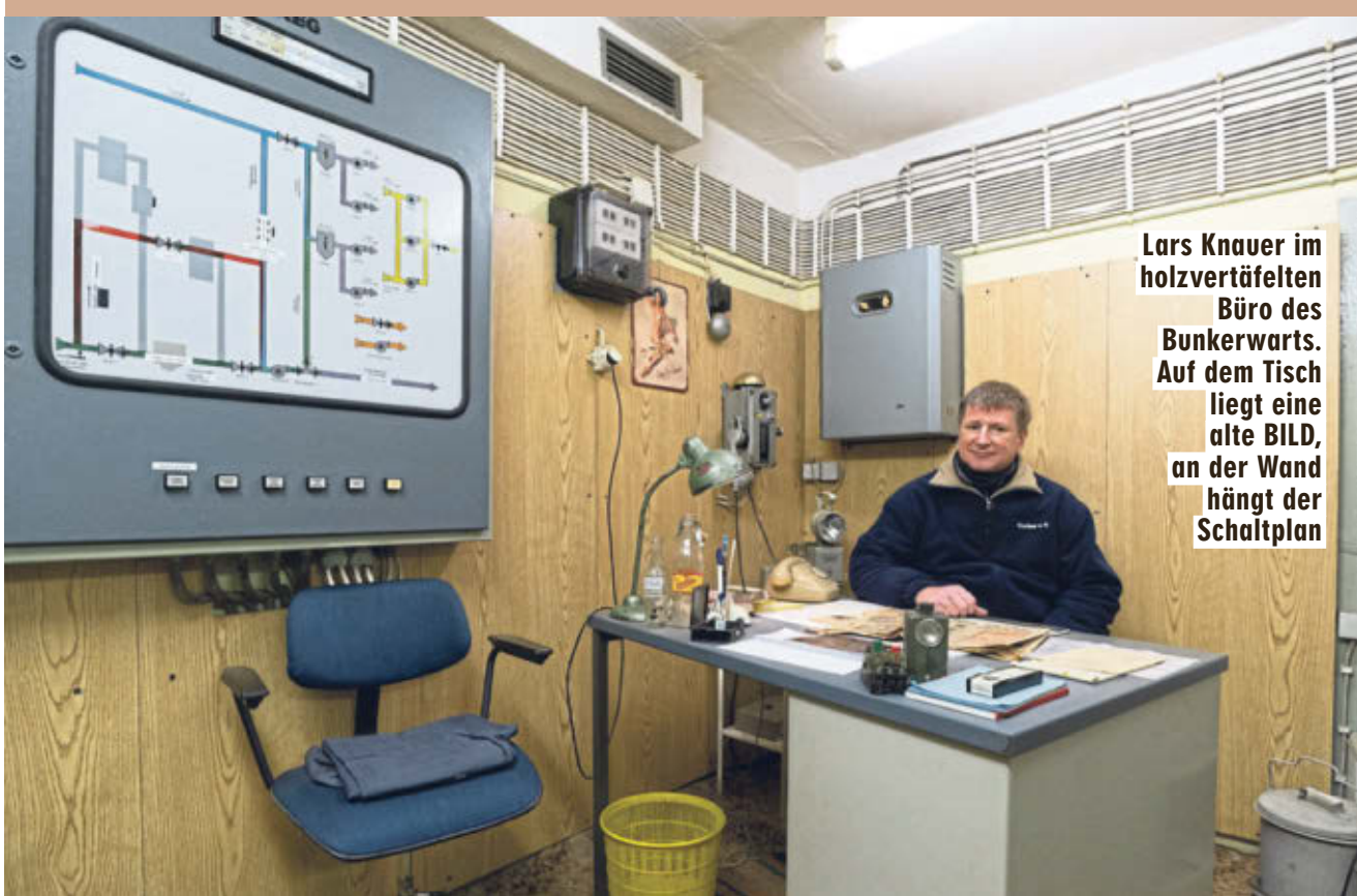
Die komplexe Elektrik des Bunkers wird von dem Verein in Schuss gehalten
