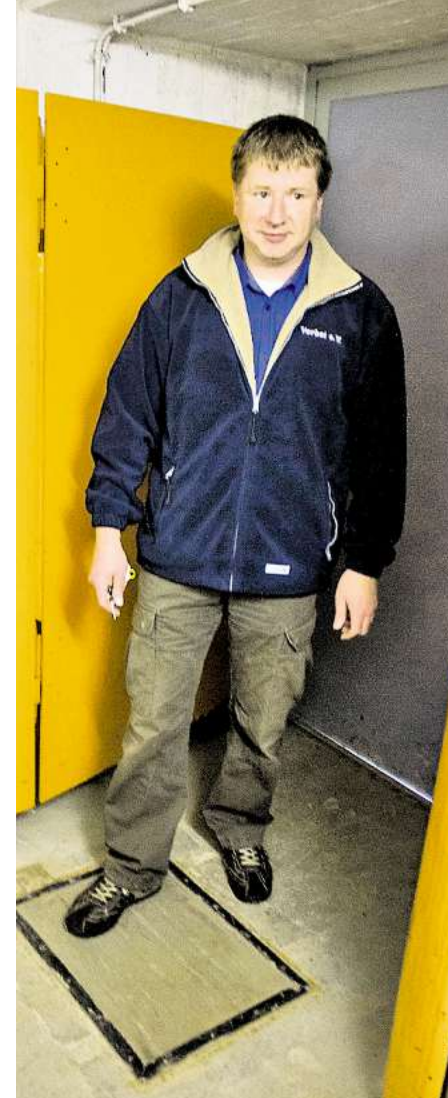
Der Bunker in der Wallensteinstraße in Ricklingen wurde zwischen 1942 und 1944 gebaut und in den Sechziger Jahren für einen Atomkrieg vorbereitet. Lars Knauer zeigt die „hydraulische Dosierschleuse“. Die Bodenplatte, auf der er steht, ist mit einem Zählwerk verbunden. Für 2400 Menschen war der Bunker vorgesehen. Fotos: Moers (6)
